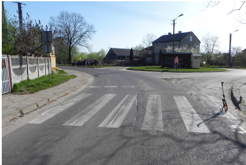
Fot 1. Oznakowanie poziome w obszarze szkoły wraz z widocznym oznakowaniem pionowym D-6 oraz T-27
